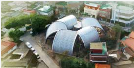
파형 강판 적용 건축 디자인 사례(포스코 1%나눔재단 발주)
