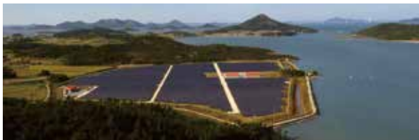
포스코에너지 신안 태양광 발전단지(3차) 전경
